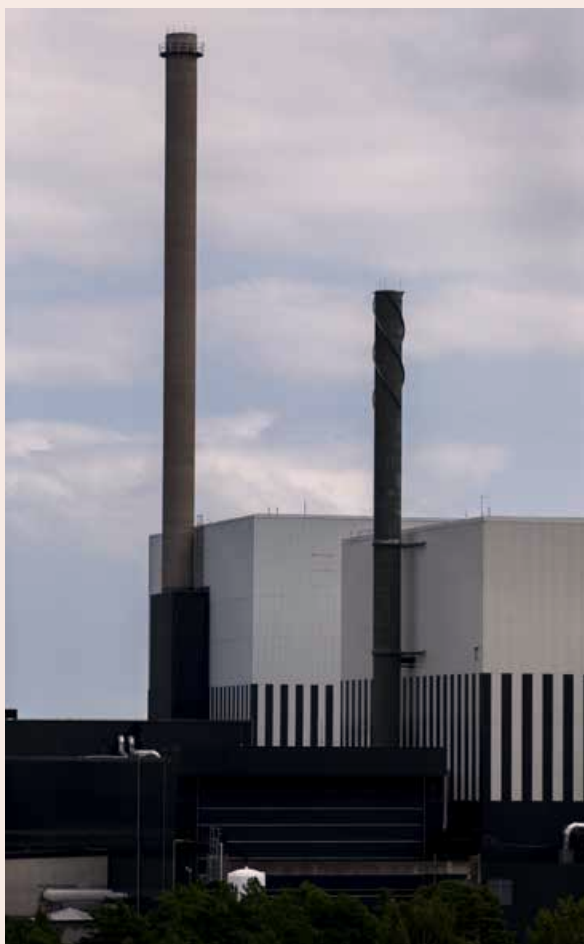
EXPORTERA EL. En rimlig målsättning för den svenska klimatpolitiken är att Sverige gör sig till stor exportör av klimatvänlig el till länder som Polen och Tyskland, för att därmed också underlätta för dem att helt få bort den miljöskadliga brunkolen. Kablarna över Östersjön finns redan, skriver Hans Bergström.
